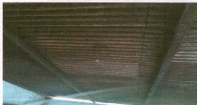
Foto 2: Se dará mantenimiento a las costaneras lo cual consiste en lijado y pintado. Cantidad de metros 24 m 2 .
