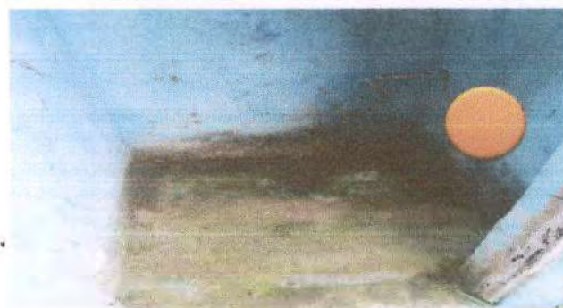
Foto 28: Instalación de mingitorio, para que los estudiantes ya no orinen en este espacio y cause malos olores.
