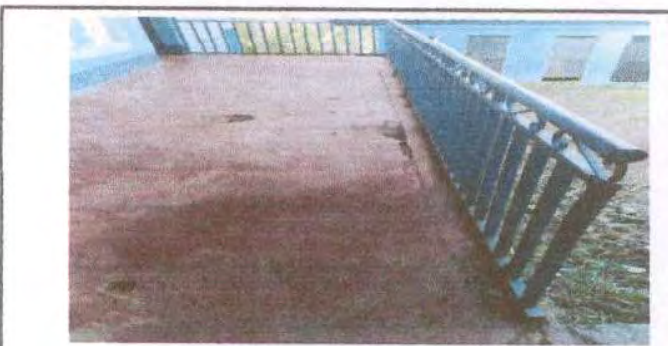
Foto 24: Sustitución de barandal de metal, por motivo que el material ferroso está picado en un porcentaje considerable. Cantidad de metros 8m 2 .
