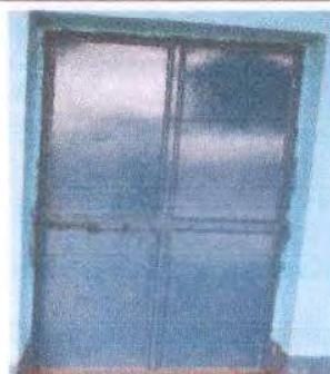
Foto 18: Reparación y mantenimiento de puerta de aula 3, por custiones de colocación de piso se tendrá que modificar. Medida de puerta 2m de altura por 1 de ancho.
