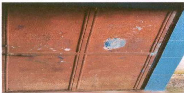
Foto 3: Cambio de puerta de la cocina escolar por deterioro en su estructura. Medidas de la puerta, 1.90 m de altura por 0.90 m de ancho.
