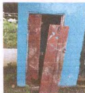
Foto 26: Sustitución de puerta madera por una de metal, medidas de las puertas 1.46 m de altura por 0.63 m de ancho.
