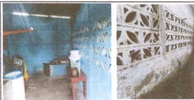
Foto 9: Repello de las paredes de la cocina, puesto que solo están cisadas, en su interior y exterior, cantidad de metros 31 m²
