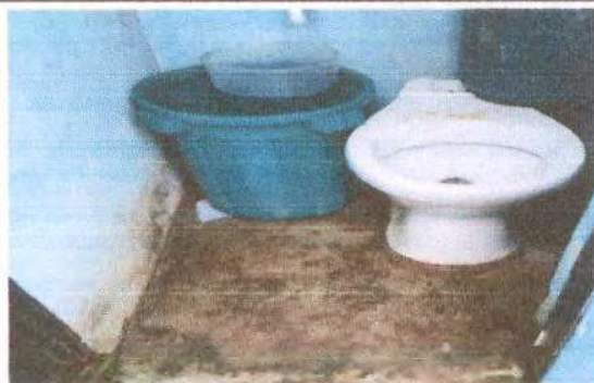
Foto 27: Colocación de piso cerámico antideslizante en los 4 espacios que conforman el módulo de baños debido al deterioro del piso liso. Total de metros 6 m².
