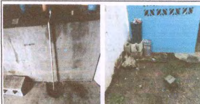
Foto 8: Sustitución de pila de cemento de un lavadero, por motivo de fuga de agua y liberar el espacio, se colocará en la parte de afuera como lo indica la imagen del lado derecho. Medidas 2 m largo por 1.20 de ancho y 0.80 m de alto.
