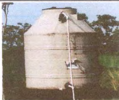
Foto 29: Se sustituirá el depósito de agua porque la cantidad de litros no abastece los días en que no llega el agua a la escuela (20 días o más). Se colocará uno de 2500 litros por uno de 1100 litros.
