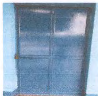
Foto 14: Reparación y mantenimiento de puerta de aula 2, por custiones de colocación de piso se tendrá que modificar. Medida de puerta 2m de altura por 1 de ancho.
